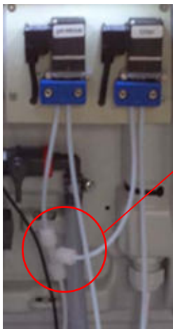
T- Stück Verschraubung (Impfstelle)
