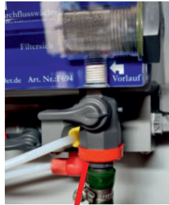
Kugelhahn ist geschlossen
