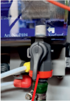
Kugelhahn ist geöffnet
