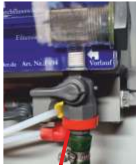
Kugelhahn ist geschlossen
